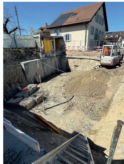
Travaux d'excavation de l'Ancienne laiterie
