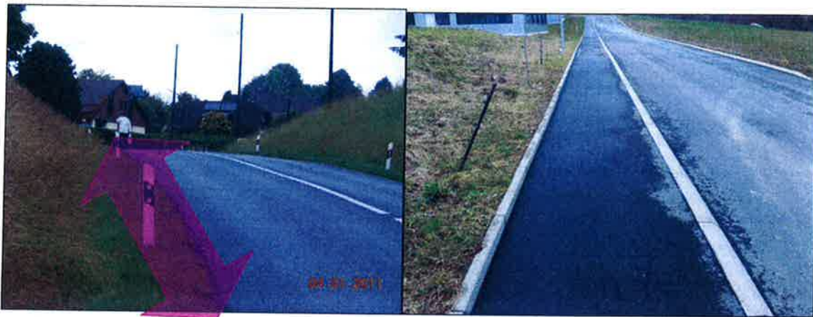
A gauche : situation avant travaux, vue vers le nord, à droite : illustration de l'aménagement de 1.7 m de large après travaux, pris à la route de Sullens, Bussigny
