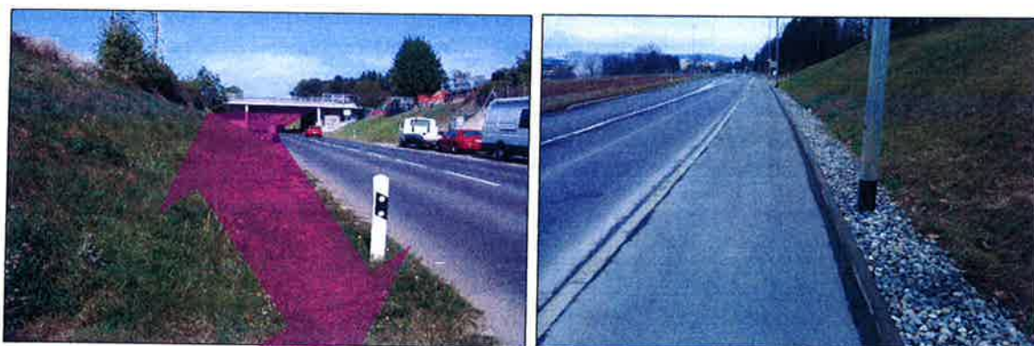
A gauche : situation avant travaux, vue vers le nord, à droite : illustration de l'aménagement de 2 m de large après travaux, pris à la route de Sullens, Bussigny
